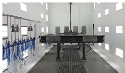
Installation dans fosse de béton
